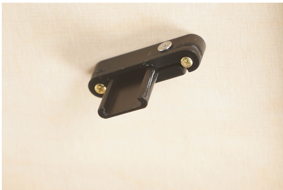
Abbildung 25: Die fest angeschraubte Schienenfixierung an der Plattenunterseite
